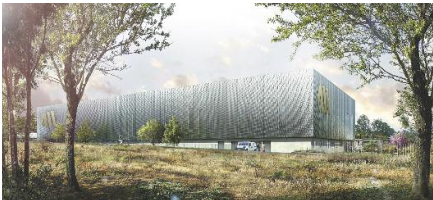
3000 bottes de paille dans leur caisson en bois isoleront le bâtiment.
