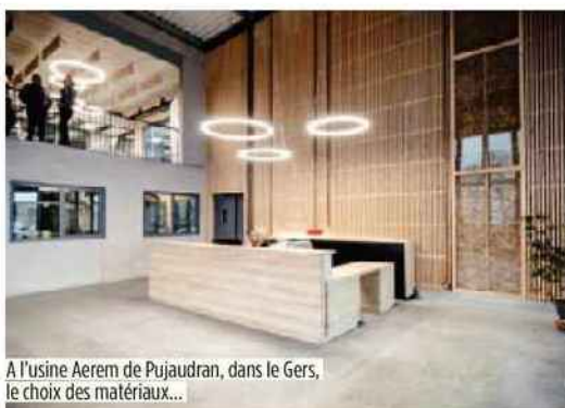
... s'est porté sur des caissons en bois démontables remplis de paille compressée.
