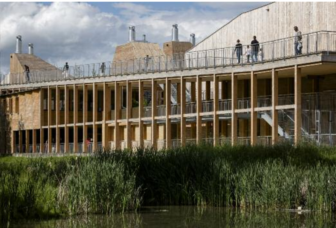
L'Aria, centre culturel réalisé en bois et terre crue par Philippe Madec en 2017, à Cornebarrieu, près de Toulouse. © Pierre Yves Brunaud
